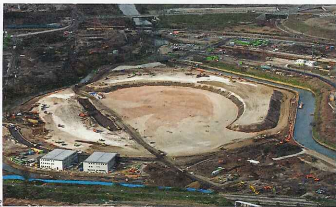
LE CHANTIER QUI ACCUEILLERA LES JO EN 2012. Ecoterres y est à l'œuvre depuis juin 2007.
